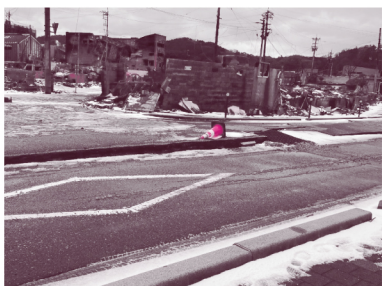
道はあちこち亀裂、液状化
