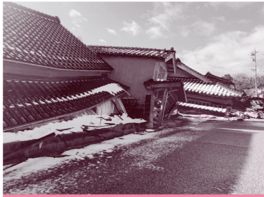
多く木造住宅は崩壊
